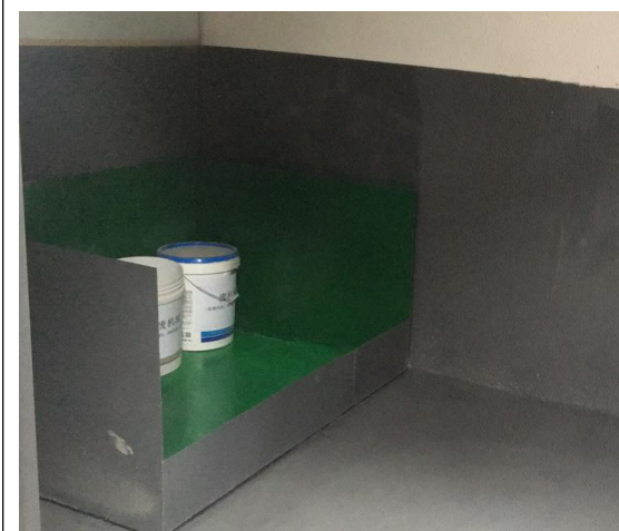
危险废物暂存间内部
