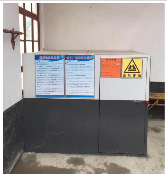
危险废物暂存间围挡
